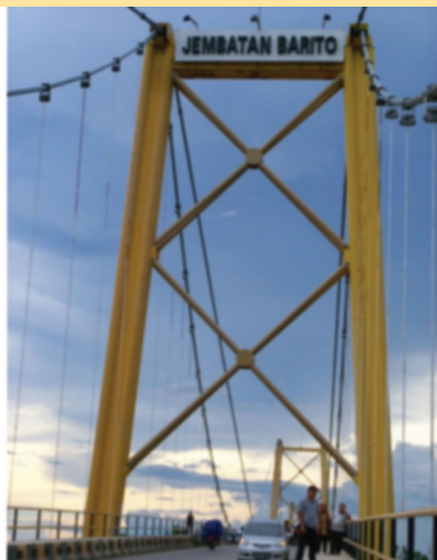
(ii) Jembatan Barito
