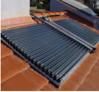
Sumber: greenoorjasolution.com Gambar 4.30 Permukaan pemanas air yang memanfaatkan panas matahari ( solar heating ) berwarna gelap atau hitam. Mengapa?
